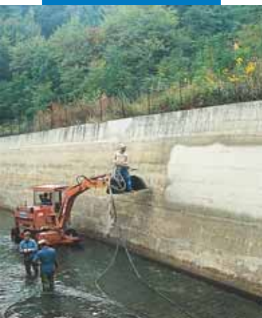
Aplicação de Idrosilex Pronto por projecção num canal hidroeléctrico
