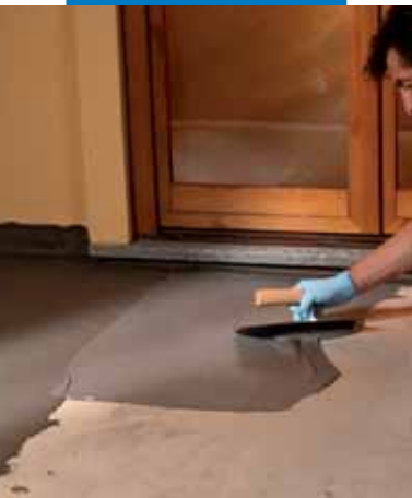
Impermeabilização de terraço com espátula
