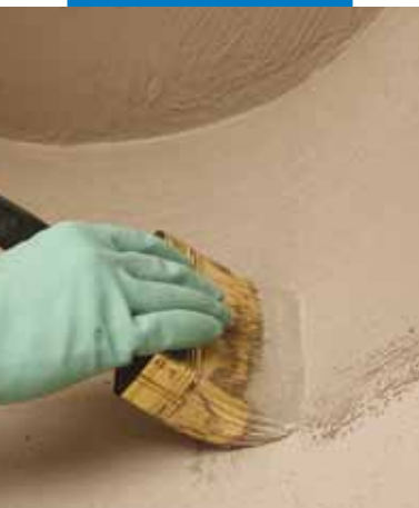
Impermeabilização de detalhes a pincel
