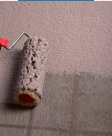
Impermeabilização de terraço a rolo
