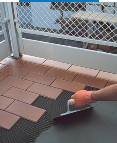
Assentamento de ladrilhos com Granirapid numa varanda impermeabilizada com Mapelastic
