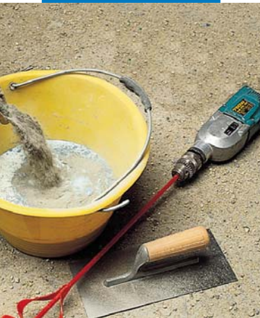
Mistura de Mapelastic com misturador mecânico
