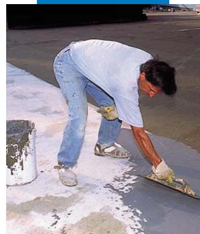
Impermeabilização de uma piscina com Mapelastic
