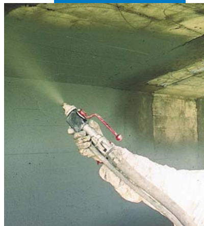
Exemplo de aplicação por projecção de Mapelastic num viaduto
