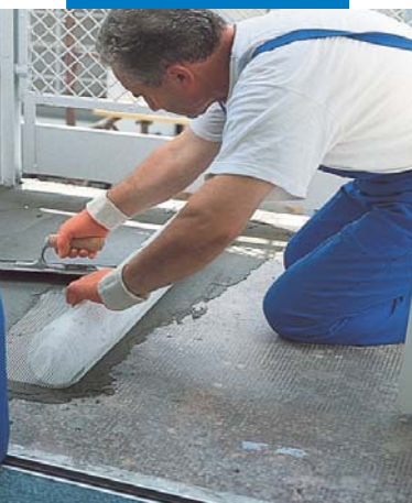
Impermeabilização de varanda com Mapelastic com aplicação de Mapenet 150
