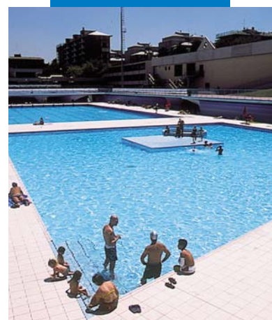
Piscina impermeabilizada com Mapelastic - Piscina Scarioni - Milão - Itália
