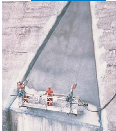
Exemplo de aplicação por projecção de Mapelastic numa barragem
