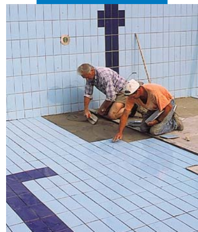
Assentamento de revestimento cerâmico sobre Mapelastic
