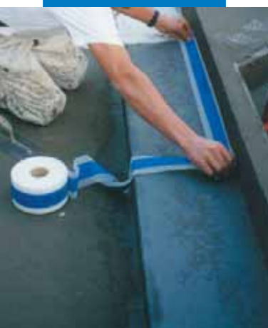
Exemplo de impermeabilização de Mapeband num ângulo entre o fundo e parte de um tanque
